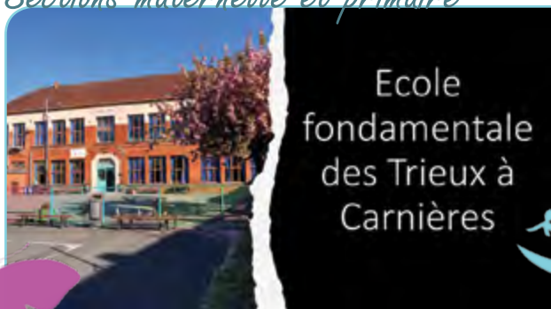
Rue des Ecoles 32 & rue Ferrer 26
