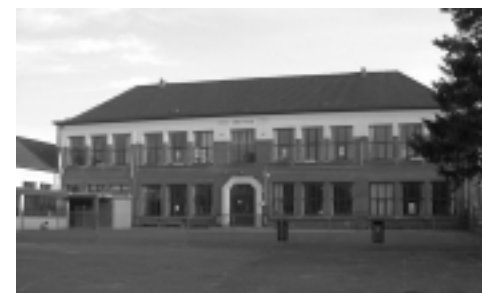
Ecole des Trieux Rue des Ecoles
