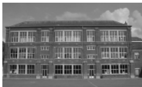
Ecole du Centre Rue Saint-Eloi (Carnières)
