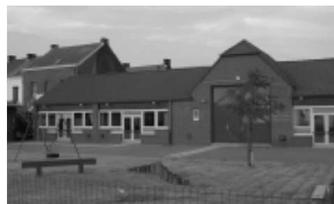
Ecole des Trieux Rue Ferrer
