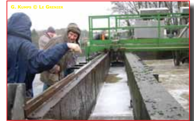
La station d'épuration I.D.E.A. Rue des Haignies
