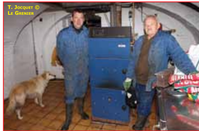
La ferme de B. Vermeulen à la rue des Boulois Culture du chicon et chaudière à céréales
